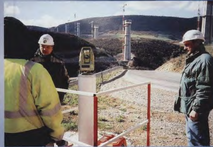
Bau des Viaduc de Millau 2003 mit Lasertheodolit.
